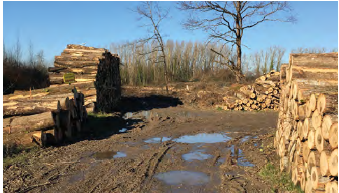
TRAVAUX SUR SITE DÉFRICHEMENT - 30 DÉCEMBRE 2019 - SOURCE : VINCENT BES (CD82)
